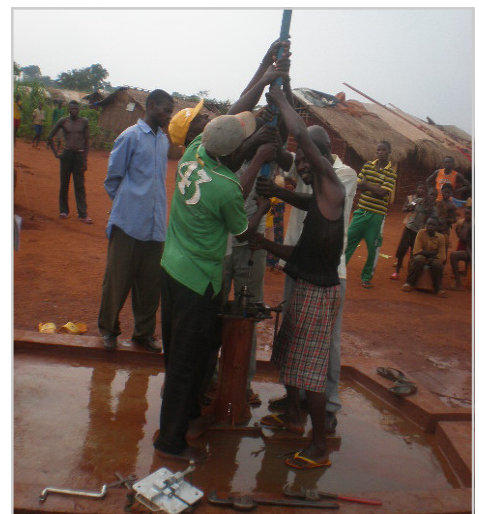
Séance pratique de maintenance d'une pompe sur le camp de Batalimo. Ph UNHCR/T. Djimbatian
