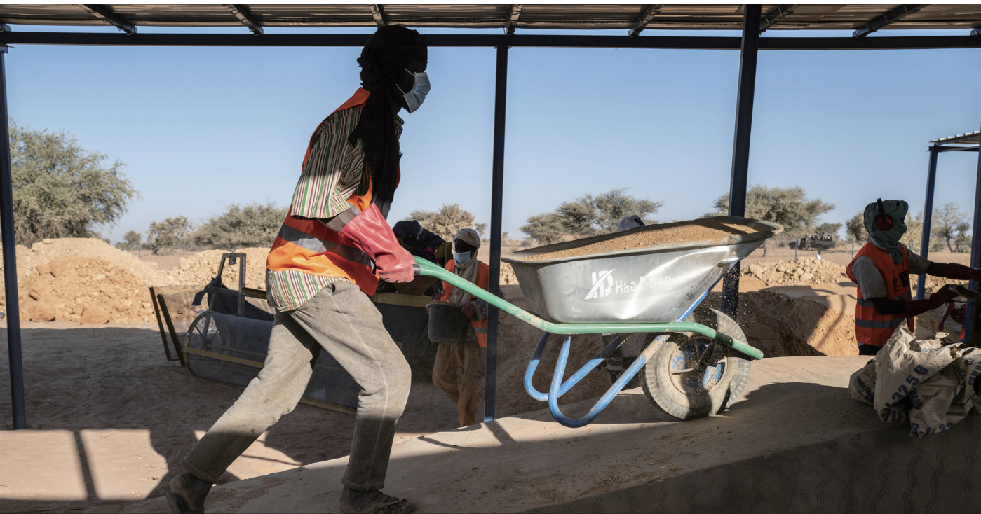
尼日尔瓦拉姆的制砖工在制作环保型联锁砖，用于为弱势难民和东道社区成员建造新的坚固房屋。
